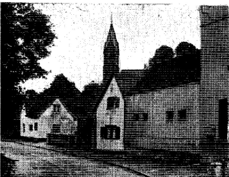
Links das Restwohnhaus des Janshofes, in der Mitte die Zahlstatt, wo der Zehnte erhoben wurde.
