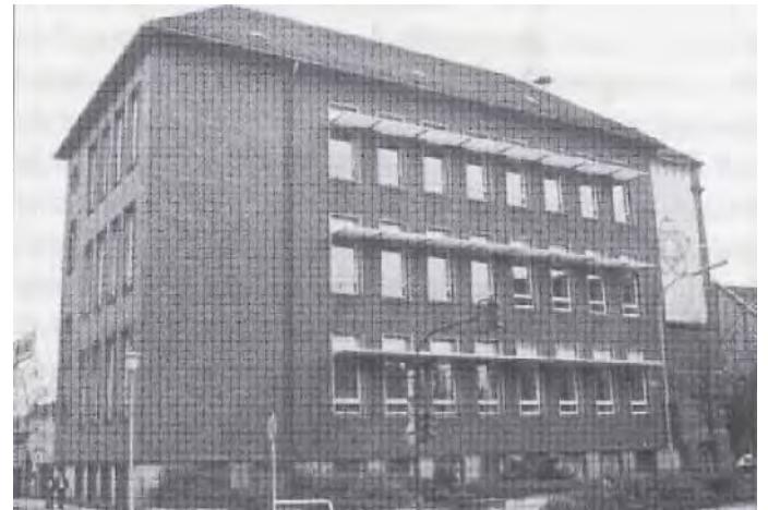
Abb. 3 Der Erweiterungsbau 1941 Foto: Slg. StAB
