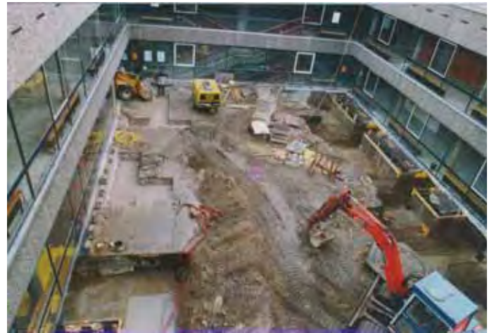
Abb. 9 Baumaßnahmen im späteren Loplop-Garten, Foto: Drösser
