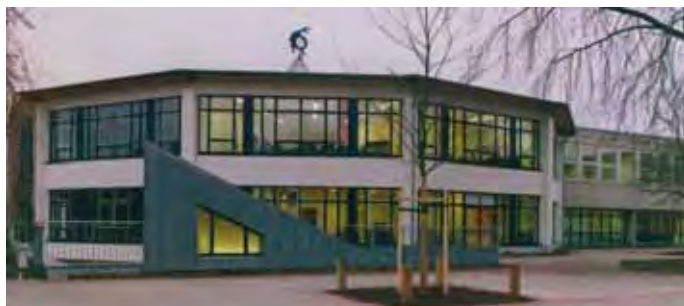
Abb. 8 Der 1. Erweiterungsbau 1995 Foto: Eckmann
