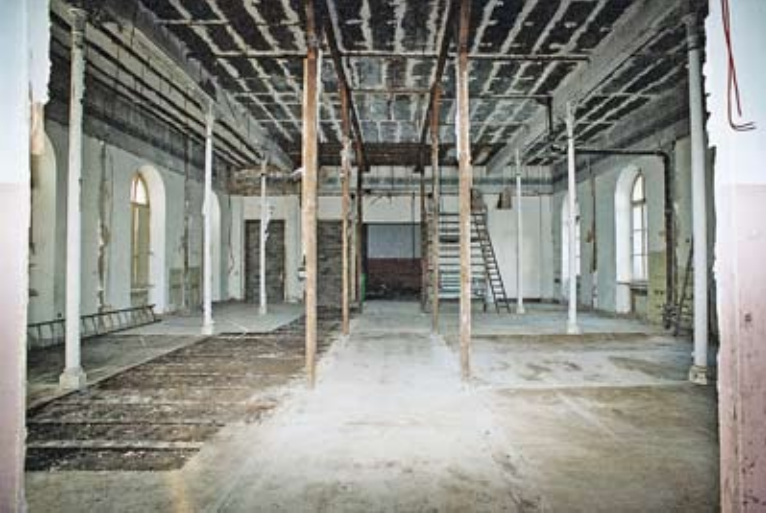
Abb. 25 Freilegung der Säulen im großen Saal / Zustand November 2002. Foto M.-L. Sobczak
