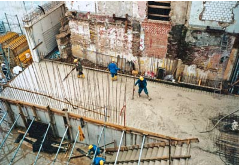
Abb. 26 Innenhof / Zustand September 2003.
