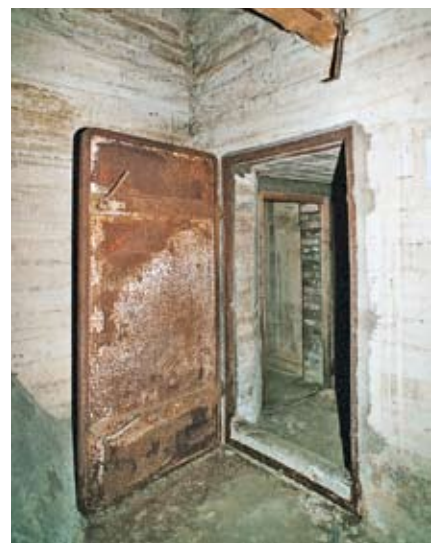
Abb. 18 Originale gasdichte Notausstiegstür von 1939 Foto 2002: M.-L. Sobczak
