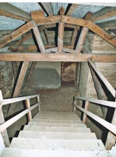
Abb. 17 Originale Abstützung (1939) des Tonnengewölbes im Zugang zum Luftschutzraum (ehem. Weinkeller von 1845) Foto 2002: M.-L. Sobczak
