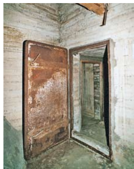
Abb. 18 Originale gasdichte Notausstiegstür von 1939 Foto 2002: M.-L. Sobczak
