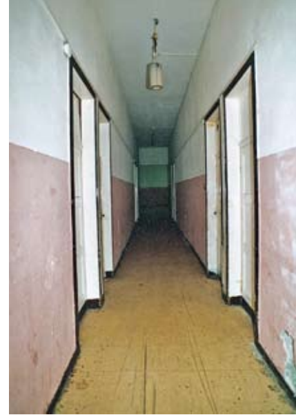
Abb. 21 Verbaute Halle im Erdgeschoss Zustand 2002
