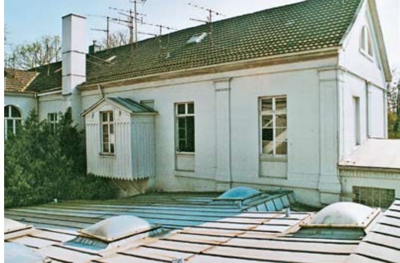
Abb. 22 Außenliegende Toilettenhäuschen / Zustand Februar 2002. Foto: M.-L. Sobczak
