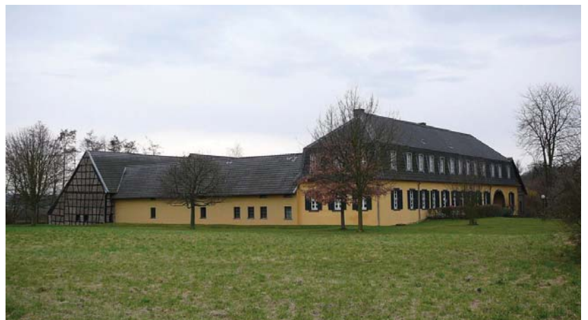
Abb. 3 Der Palmersdorfer Hof (von Nordosten)
