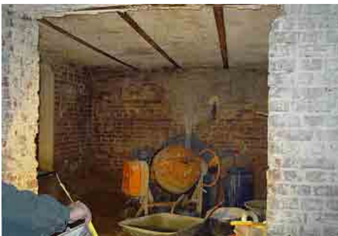
Abb. 12 Erneuerung des Fußbodens. Blick aus dem Anbau in den Altbau. Die Maueröffnung entspricht dem ursprünglichen Fenster in der Gebäudefront auf Abb. 4. Quelle: Sammlung H. W. Breidenbach
