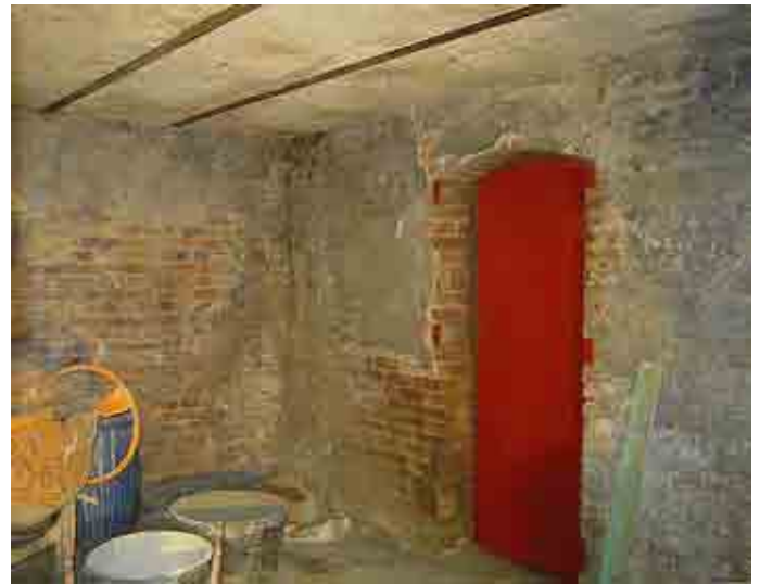
Abb. 13 Reste von Ornamenten auf altem Wandputz. Quelle: Sammlung H. W. Breidenbach
