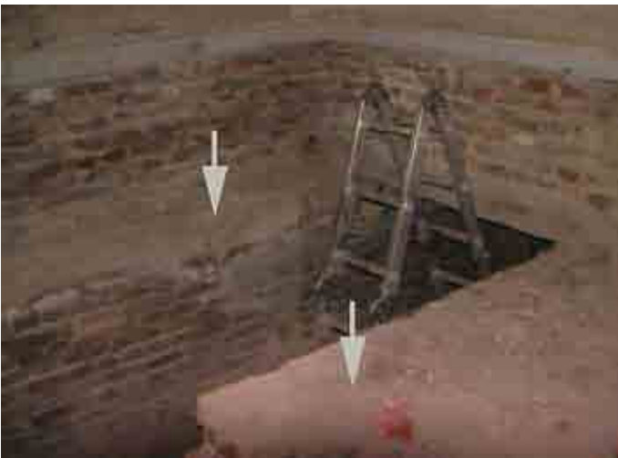
Abb. 6 Gleisfundamente. Quelle: Sammlung H. W. Breidenbach
