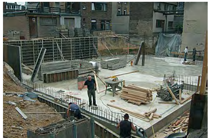
Abb. 4 Bauarbeiten für das neue Begegnungszentrum Foto: Markus Dörstel
