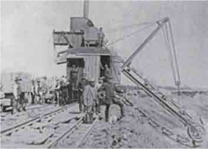
Abb. 4 Eimerketten-Dampfbagger. Foto um 1900 (aus: „Braunkohlenbergbau im Rheinland“. Wernersche Verlagsgesellschaft, Worms 2008)
