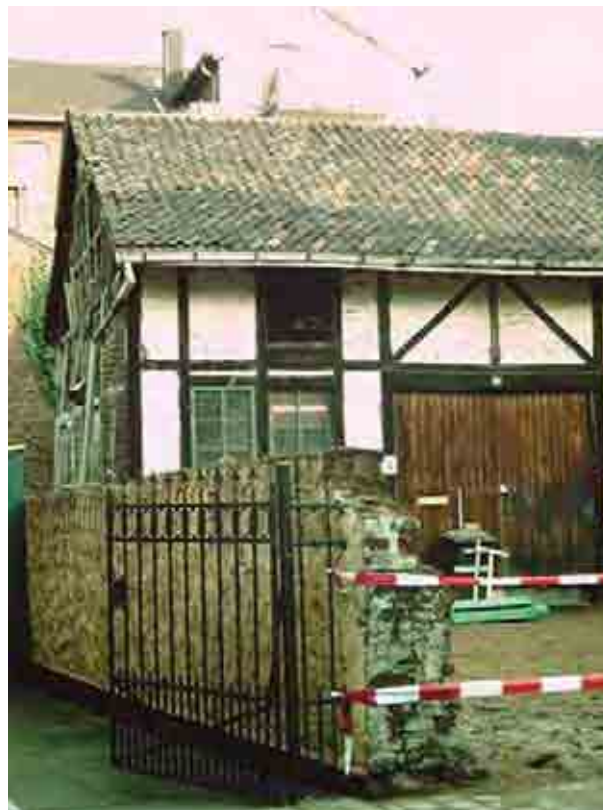
Abb. 1 Front der ehemaligen Stellmacherei in der Kempishofstraße – Ende 1998. Zustand am Beginn der Sicherungsarbeiten
