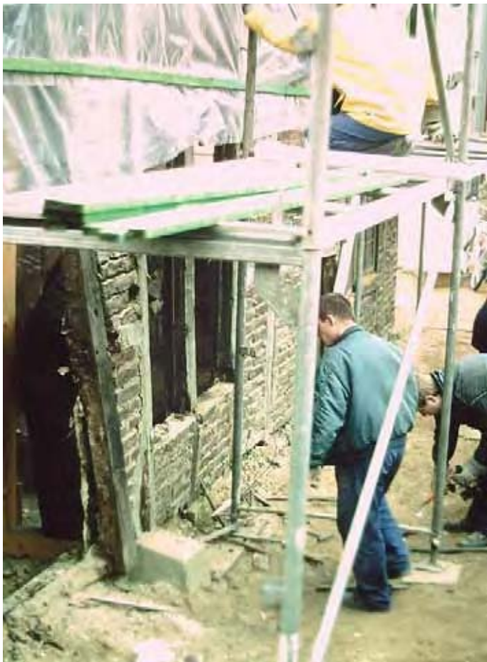
Abb. 4 Sicherungsarbeiten am Westgiebel
