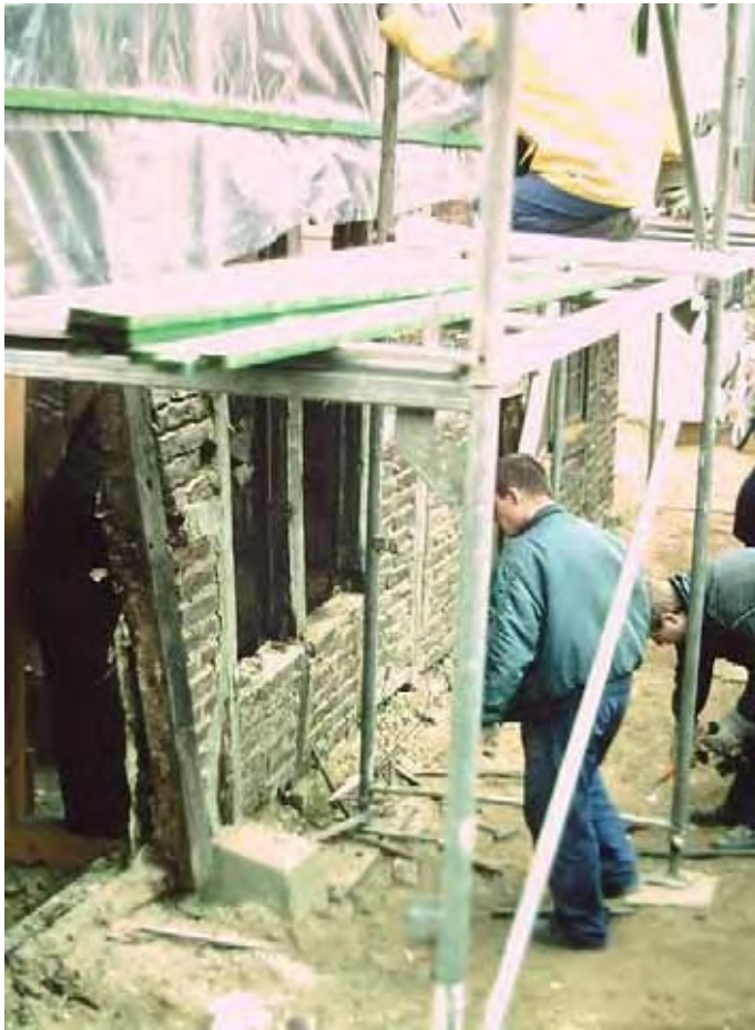
Abb. 4 Sicherungsarbeiten am Westgiebel
