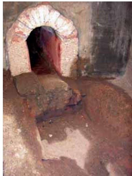
Abb. 28 Rekonstruiertes Wasserleitungs-Teilstück in der „Brunnenstube“ bei Mechernich-Kallmuth Foto: G.-U. Knackstedt
