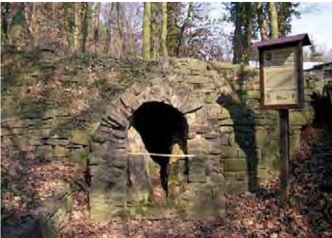
Abb. 30 Aufschluss der Eifelwasserleitung in Euskirchen-Kreuzweingarten
